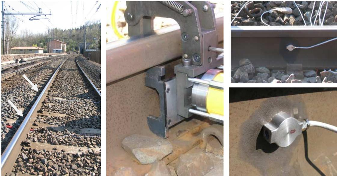
Figura 8: Vista generale del sito nel quale è stato installato il dimostratore (a sinistra). Operazione di montaggio (forzamento) con attrezzatura dedicata (al centro). Viste finali di sensori montati in opera (a destra).
