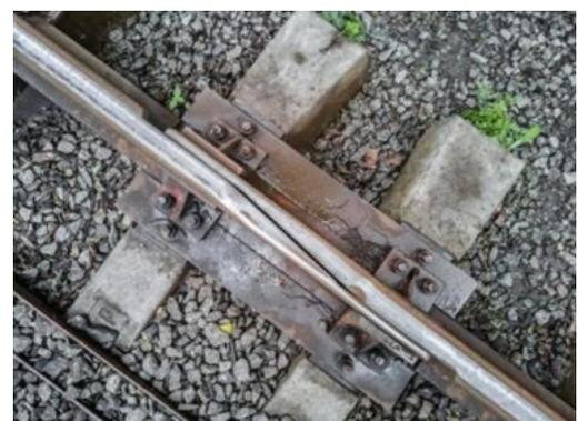
Figura 2 - GII con taglio a 30° (sinistra) [7]; giunto di dilatazione ottenuto da rotaie piegate (destra).
