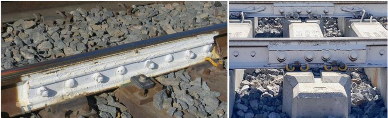
Figura 1 - GII con otto chiodi di bloccaggio (sinistra) [3]; GII supportato da una traversa speciale (destra).
